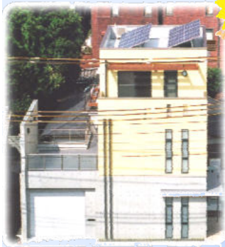
自宅屋上に設置されている太陽光発電
